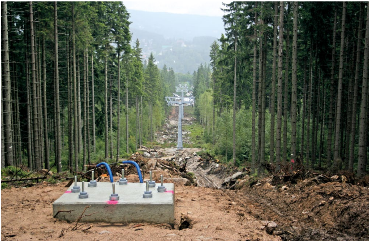
Szrenica, Karkonosze, budowa kolei linowej. W 2010 r. wszczęto postępowanie w sprawie stwierdzenia nieważności DoŚU dla tej inwestycji. Fot. Radosław Ślusarczyk
