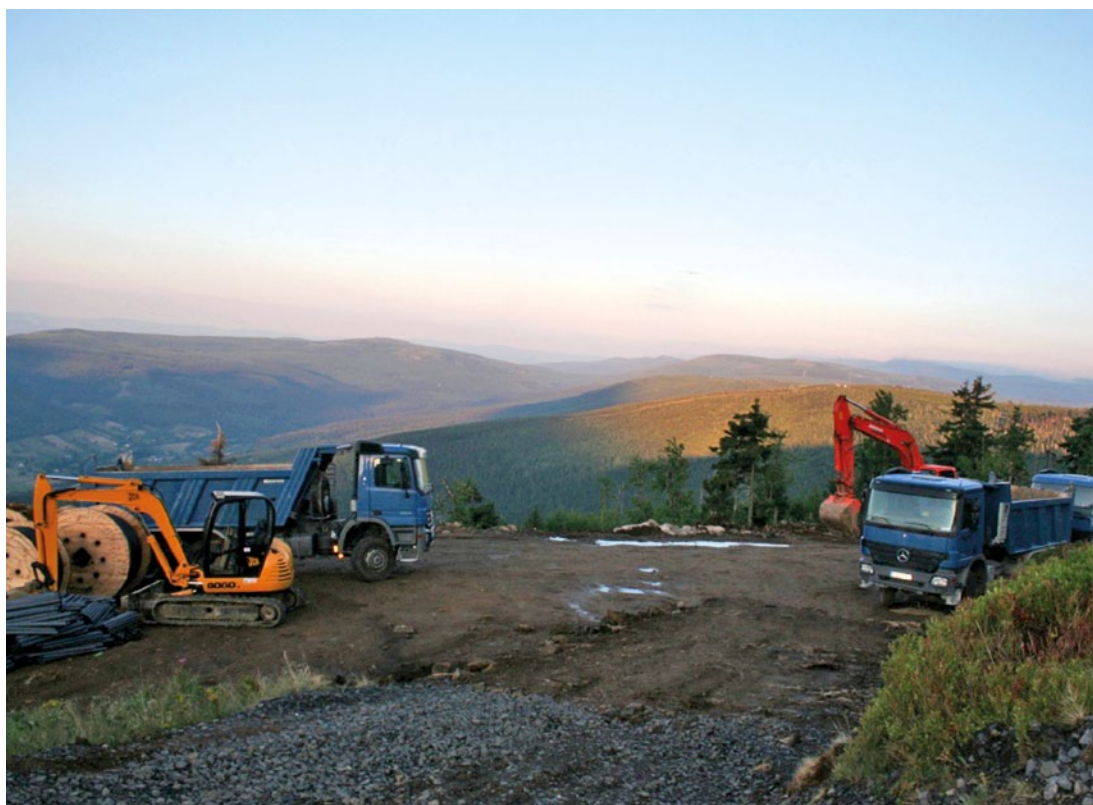
Prace budowlane przy budowie ośrodka narciarskiego na Stogu Izerskim. Fot. z archiwum Pracowni
