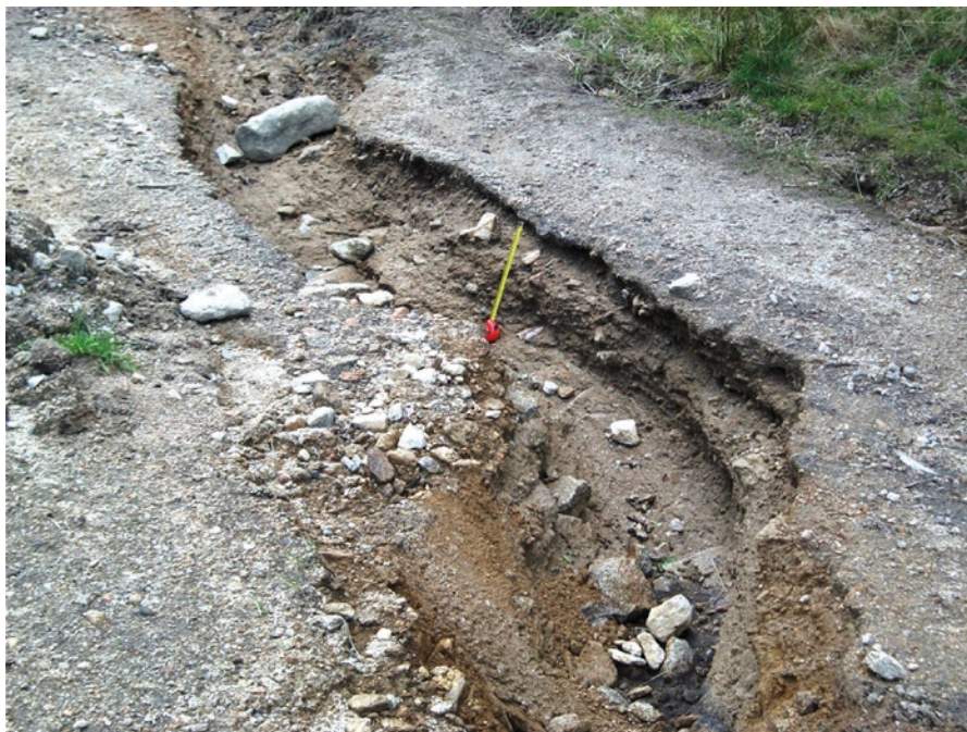
Ryc. 9. Nasilona erozja w dolnym odcinku nartostrady Lolobrygida (zachodnie Karkonosze), gdzie w okresach bezśnieżnych odbywa się turystyczny ruch pieszy.
